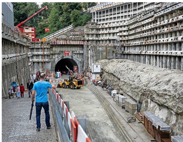
Besucher begutachten die Baustelle Hirschenpark des RBS. Foto: Key
